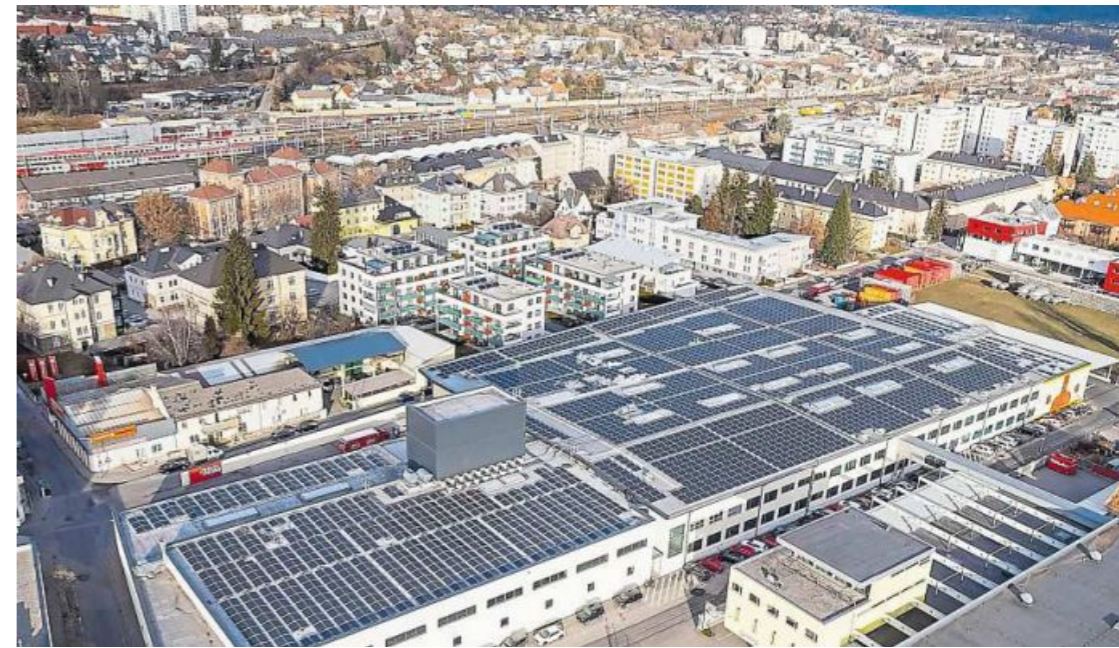
Das Sonnenstrom-Kraftwerk auf der Villacher Brauerei liefert Energie für 462 Haushalte
